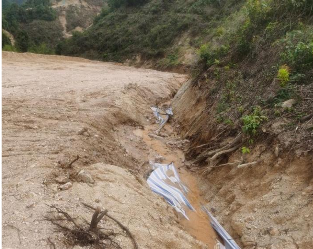
照片9 排水沟1修复前
