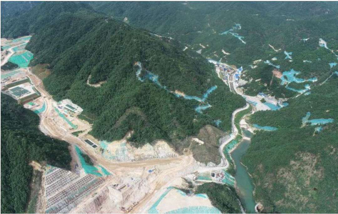
照片2 选矿和采矿工业场地占损全貌
