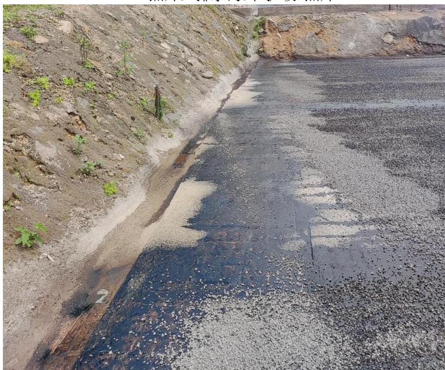
照片32排水沟5照片
