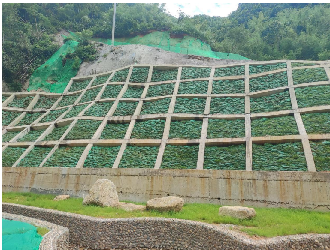
照片38护坡区5照片
