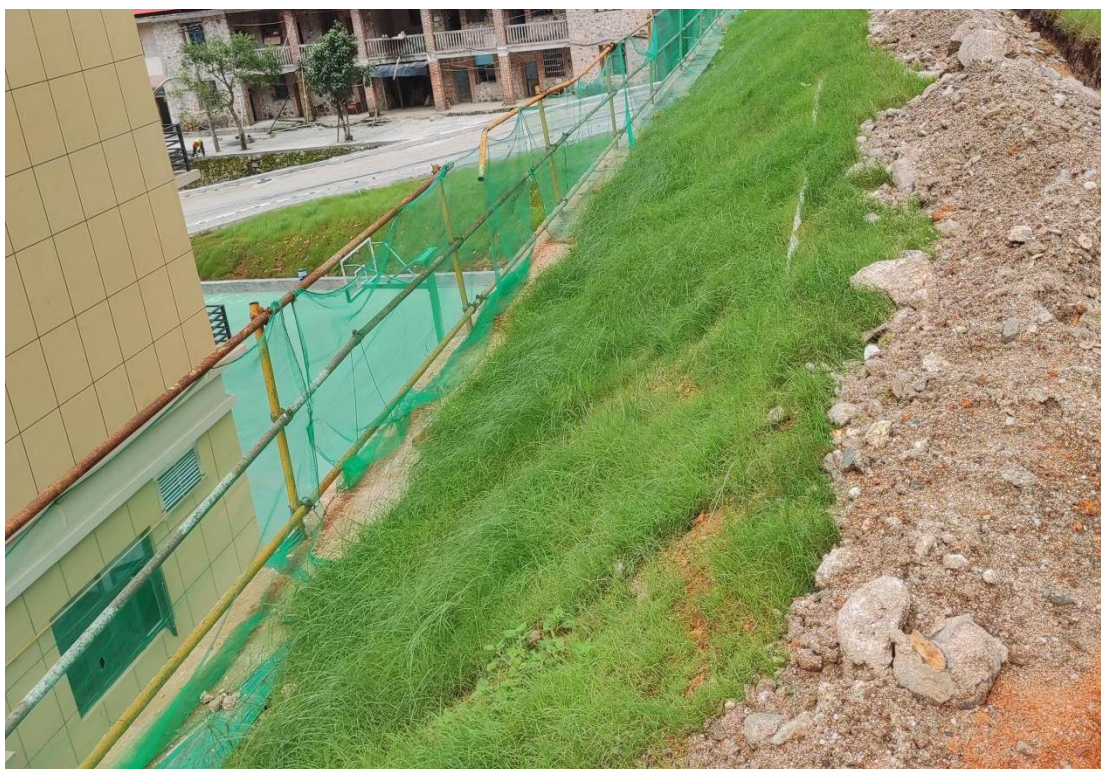
照片35 边坡复绿区4照片
