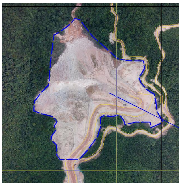
照片4-5 排土场破坏地形地貌景观
