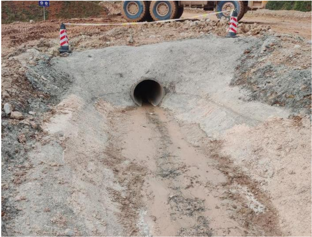
照片15 排水沟3和涵管
