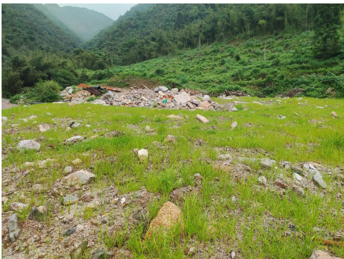
照片27边坡复绿区3照片
