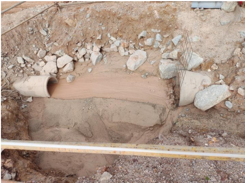
照片16 排水沟3和涵管
