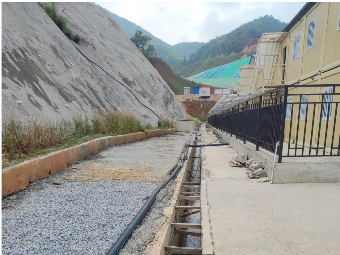
照片21护坡2和排水沟2
