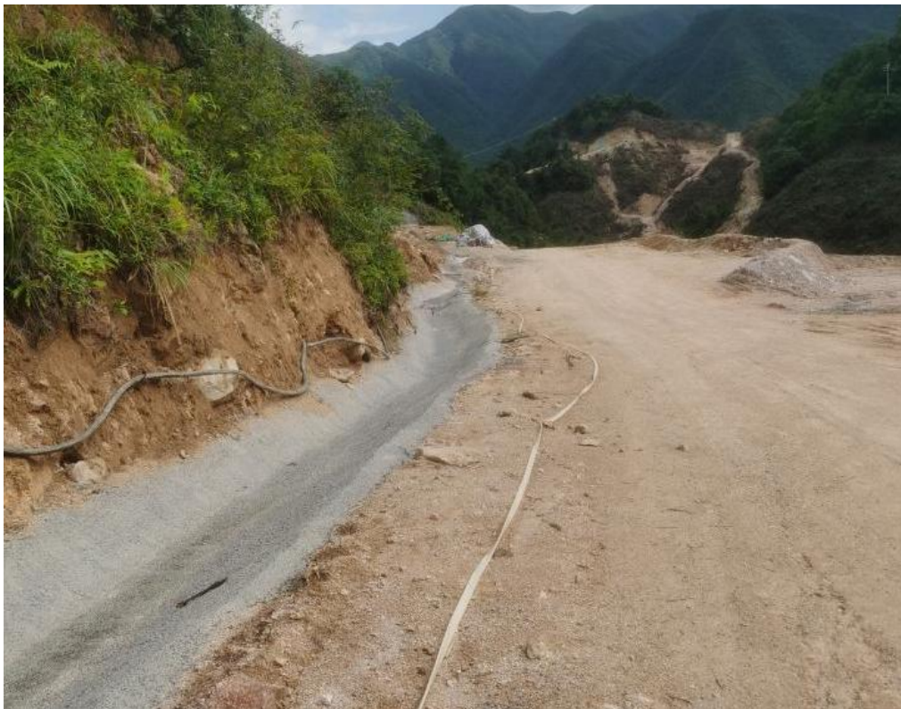
照片10 排水沟1修复后
