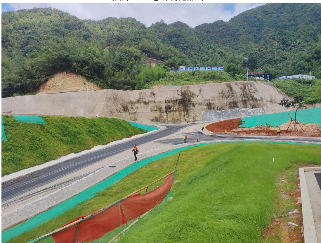
照片30 护坡区4照片
