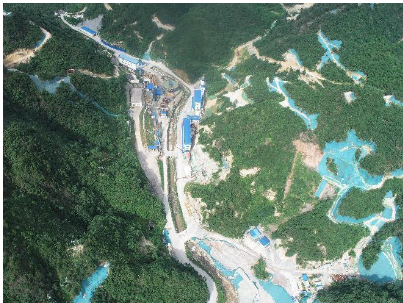
照片4-4 采矿工业场地破坏地形地貌景观
