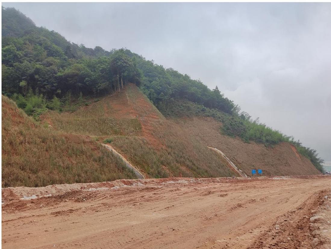
照片25边坡复绿区1修复后
