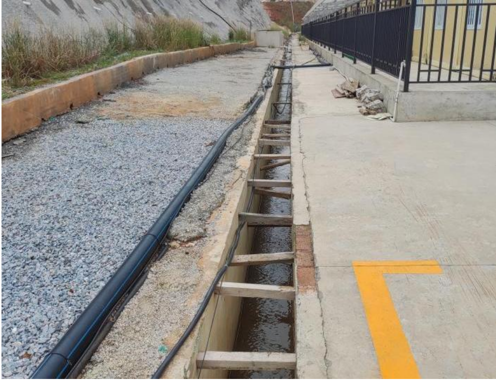
照片19护坡2和排水沟2
