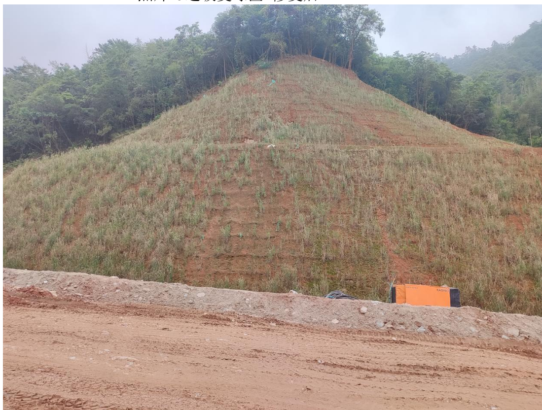
照片26边坡复绿区1修复后
