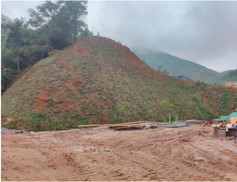
照片17边坡复绿区2
