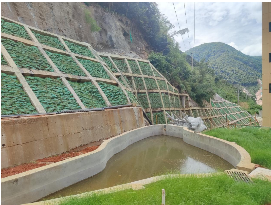
照片37护坡区5照片
