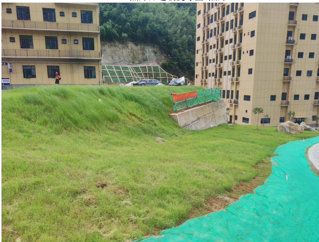
照片34边坡复绿区4照片
