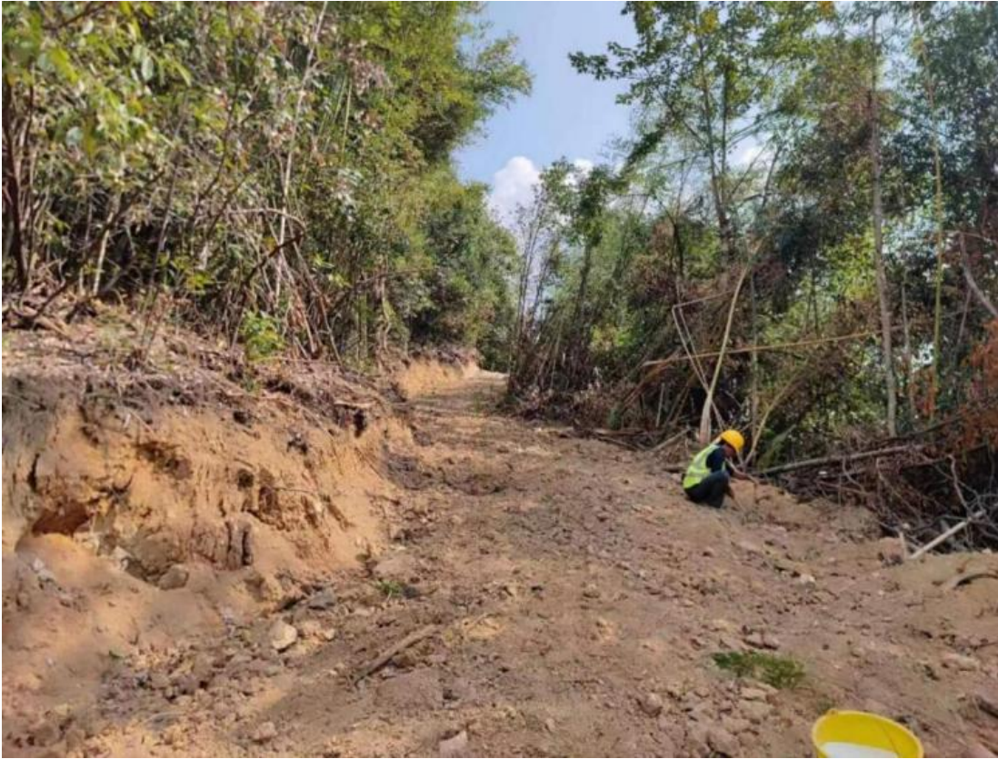
照片5林地复垦区2修复前
