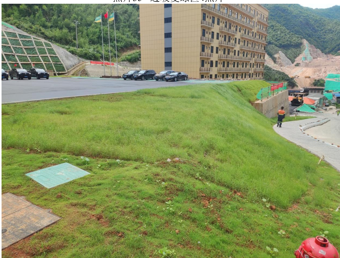
照片36 边坡复绿区4照片
