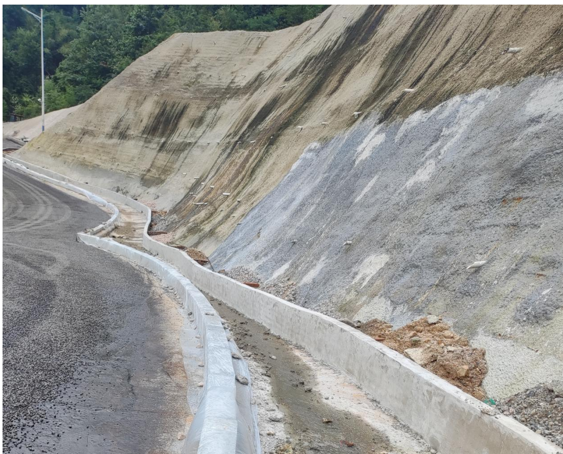
照片31排水沟5和护坡4照片
