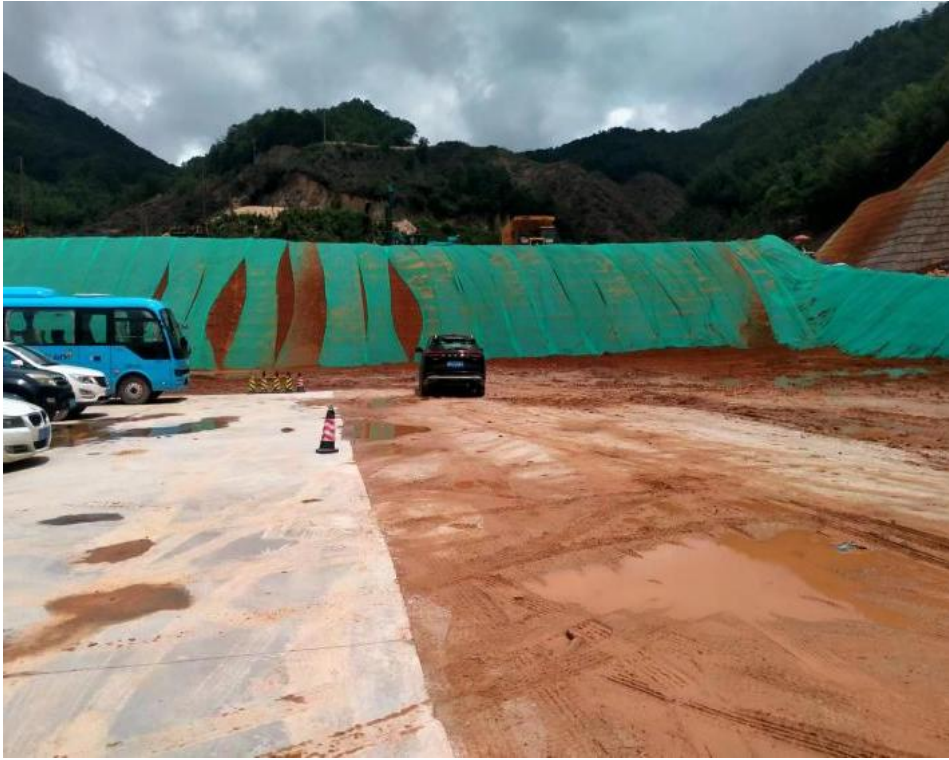
照片13林地复垦区4修复前
