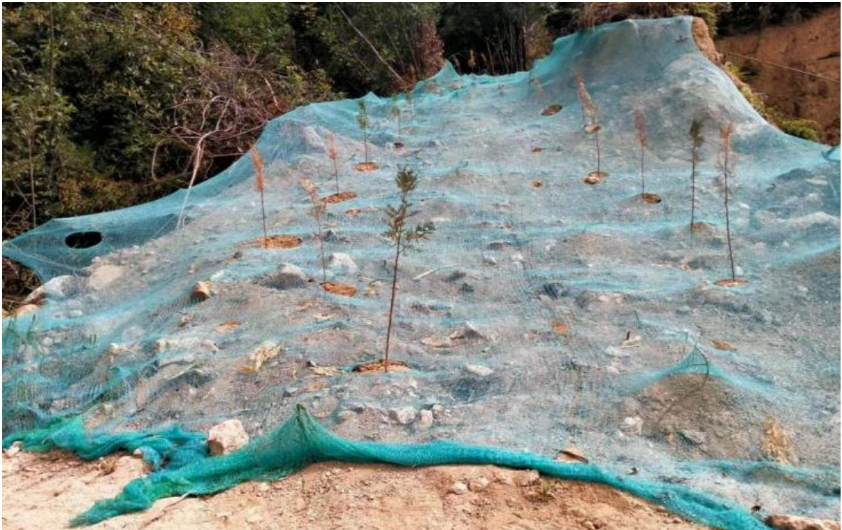
照片6林地复垦区2修复后
