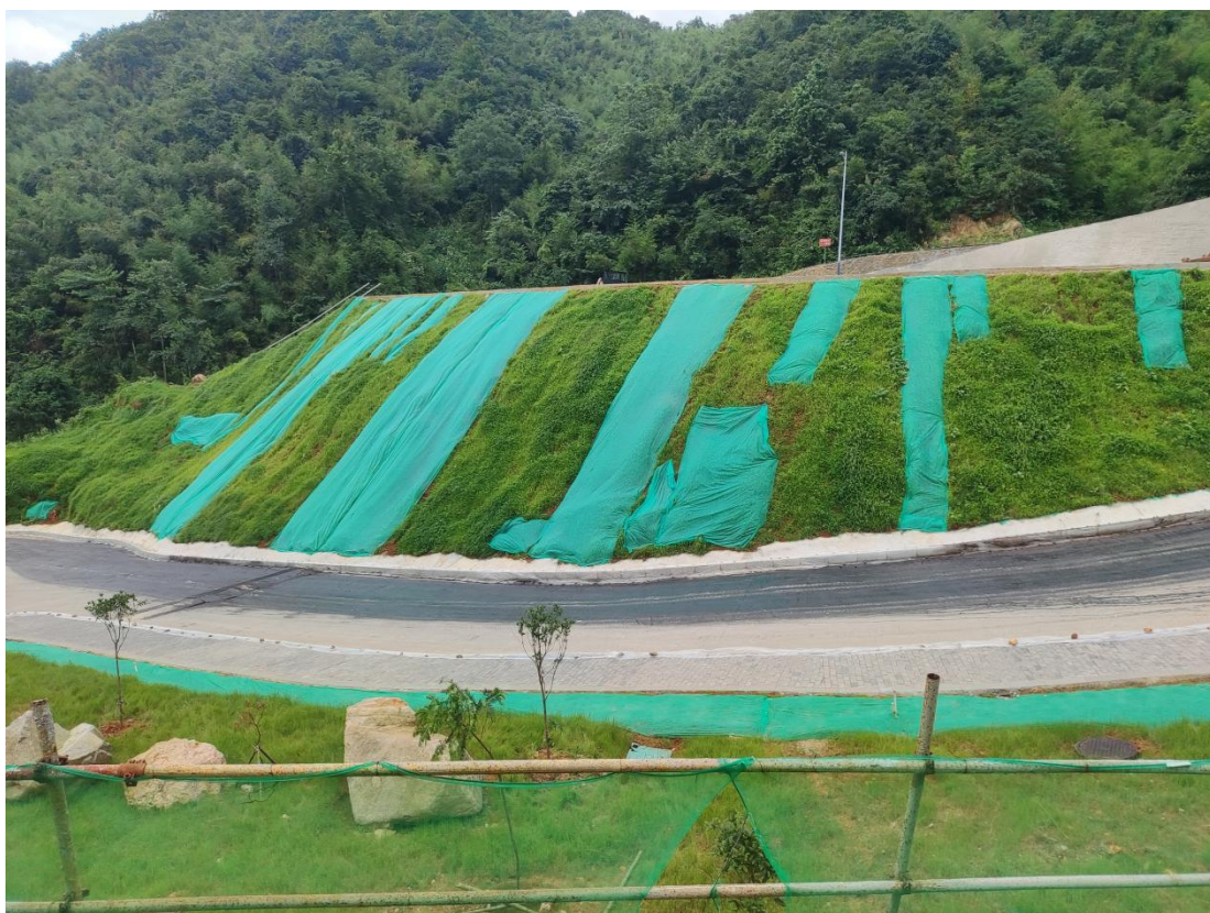
照片33边坡复绿区4照片
