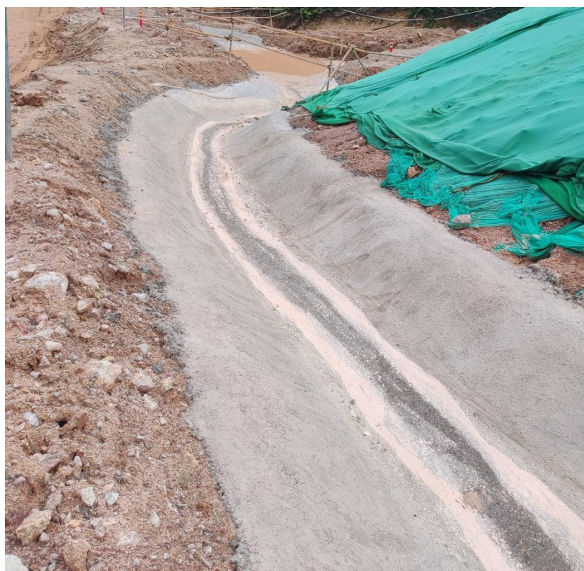
照片22 排水沟2和沉砂池2
